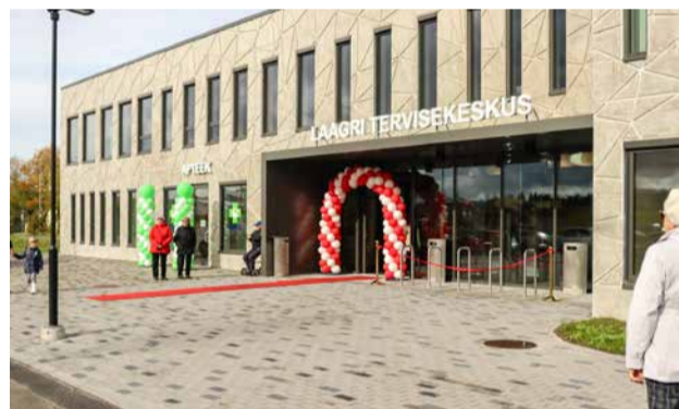
Uues Laagri tervisekeskuses tegutsevad koos perearstid, hambaravi, apteek ja vallamaja haridus- ja sotsiaalosakond
